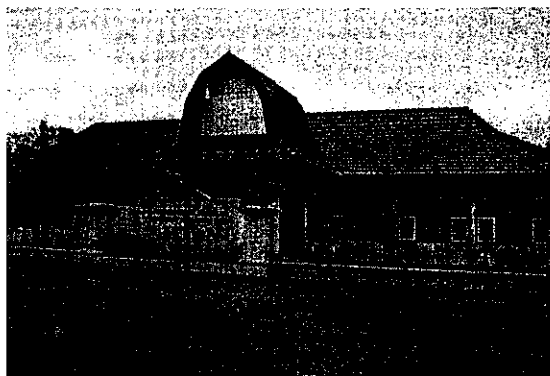
MTsN Kuripan, Lombok Barat, Nusa Tenggara Barat
